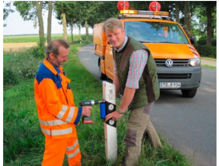
Ulf Ahrens assistiert bei der Montage eines Reflektors. Sie helfen bei der Vermeidung von Wildunfällen. FOTO: WILSHUSEN
